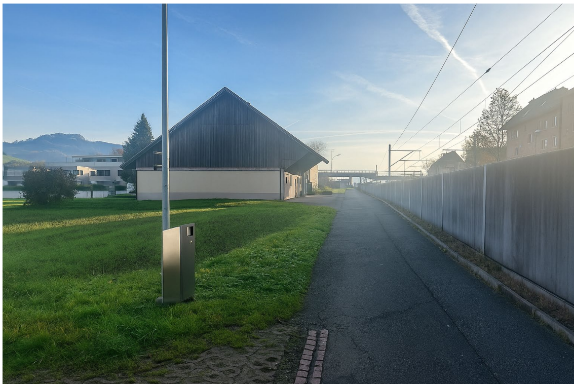
Ansicht Parallelweg Richtung Osten
