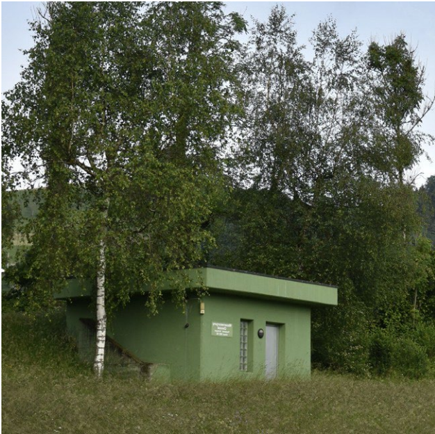
Grundwasserpumpwerk farblich recht gut angepasst, vor einer Gehölzgruppe. Eine noch dunklere Farbe würde die Einpassung noch verbessern.
