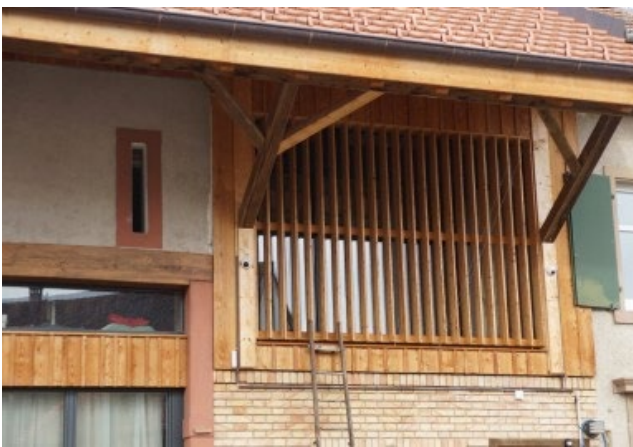
Verkleidung der neuen Fensteröffnungen im Scheunenteil mit offener Holzlattung zur Kaschierung von atypischen grossflächigen Fensterfronten
