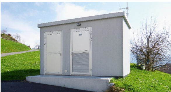
Trafostation schlecht eingepasst
