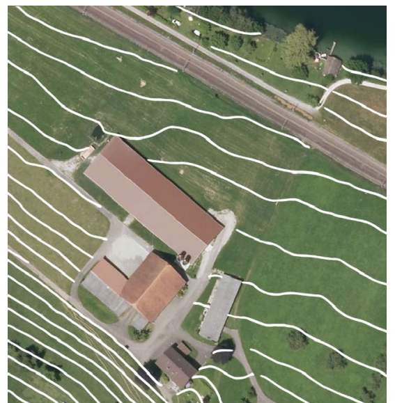
Neues Gebäude ist parallel zum Hang gut situiert.
