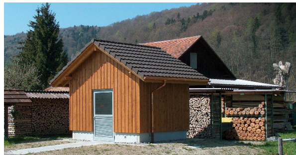
Trafostation mit Holzverkleidung, gut in die Umgebung eingepasst
