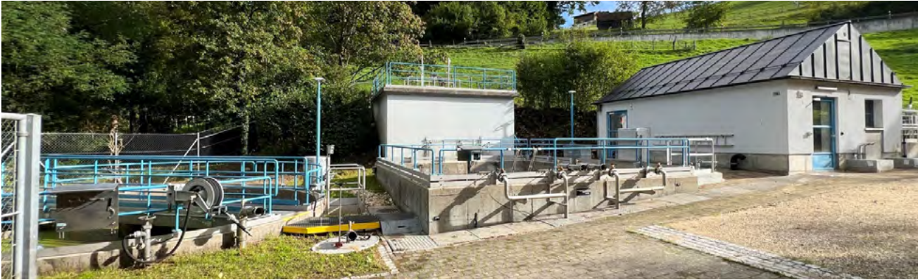
Die Kleinanlage der ARA Lampenberg nach der Sanierung.
