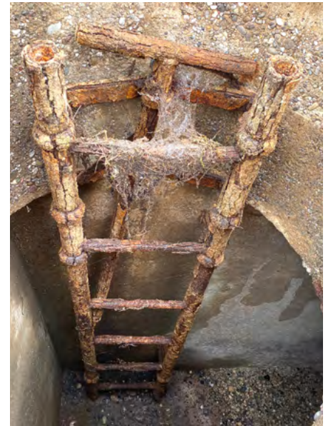
Sieht aus wie ein archäologisches Fundobjekt ( Bild rechts ), wurde schon sehr lange nicht mehr begangen und musste ohne Zweifel ersetzt werden – links eine neu verbaute, korrosionsbeständige Leiter.
