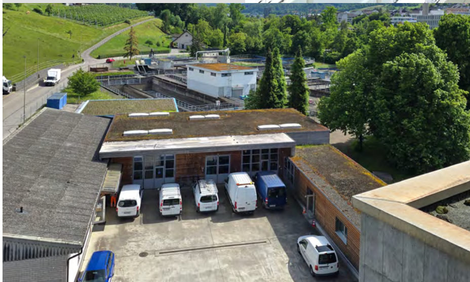
Blick ins Areal der ARA Ergolz 2 in Füllinsdorf sowie ein Ausschnitt aus dem digitalen 3D-Modell (oben) der zukünftigen Anlage.
