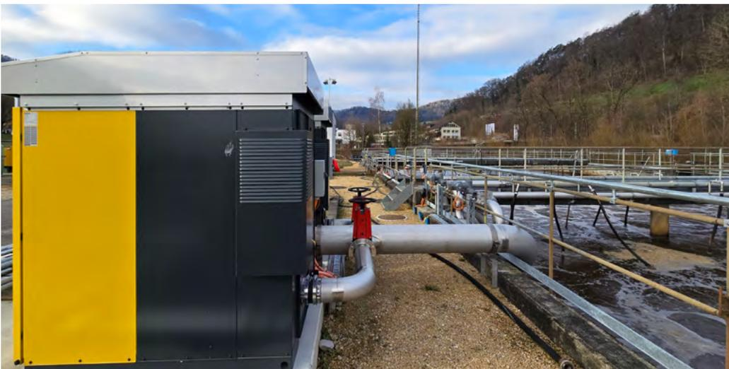
Die ARA Frenke 2 in Niederdorf ist rundum saniert worden. Sie erhielt unter anderem eine neue Fällmittelstation (oben) sowie ein neues, wartungsarmes Gebläse für die Biologie (unten).
