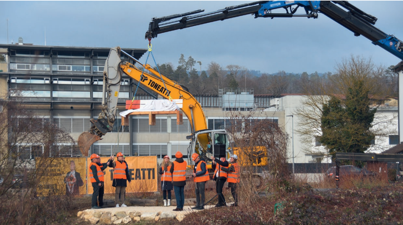
Bauen ist ein Gemeinschaftswerk. Die Offiziellen griffen deshalb zu Seilen statt einem Spaten und platzierten miteinander am Birsufer eine Baustellenbank (Quelle: BUD)
